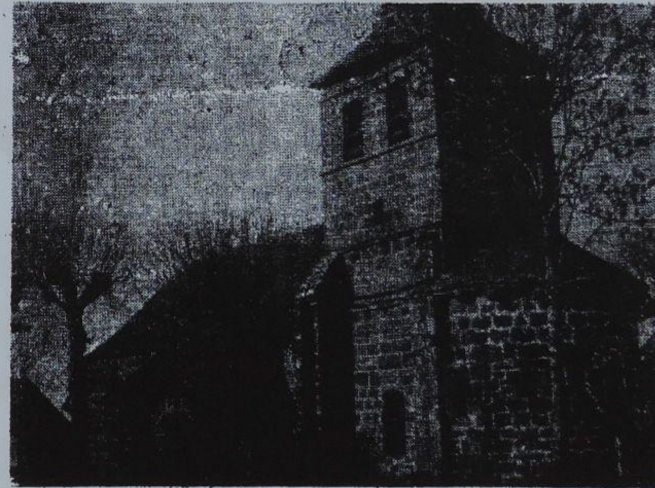
L'Eglise de Saint-Martin Cantalès en voie de restauration.
